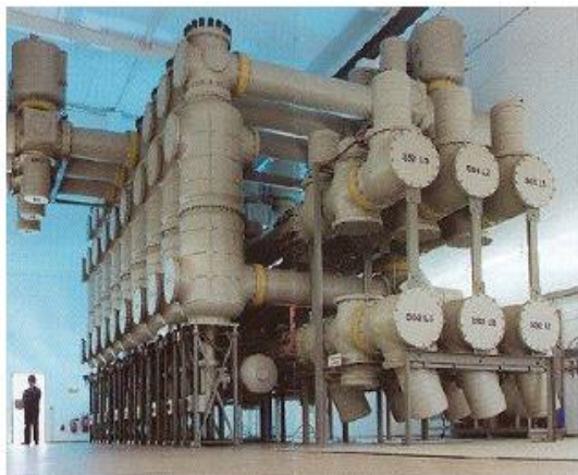
Fig. 3.31. Subestacion aislada en gas SF 6
