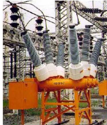
Fig. 3.22 Interruptor tipo soplo en SF6, tanque muerto, marca: Alsthom, tipo: DT1-145F1 de 145 kV, 2000 A, 40 kA de capacidad interruptiva con mecanismo de resorte.
